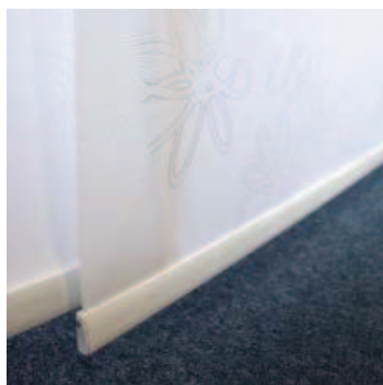
Detail spodní lišty posuvného panelu
